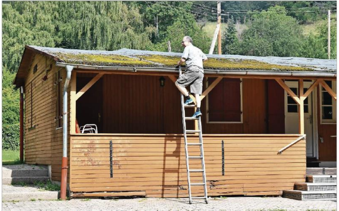
Die für 2019 geplante Dachsanierung des Vereinsheims „Sonnengarten“ für 21 000 Euro soll dieses Jahr endlich umgesetzt werden.
